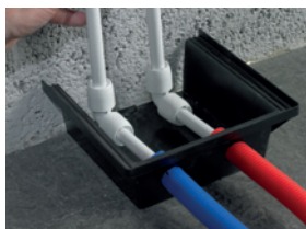
Fig. 38 Cut conduit box for wall termination
