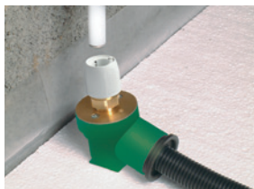
Fig. 45 HX101/15W conduit terminal installation procedure
